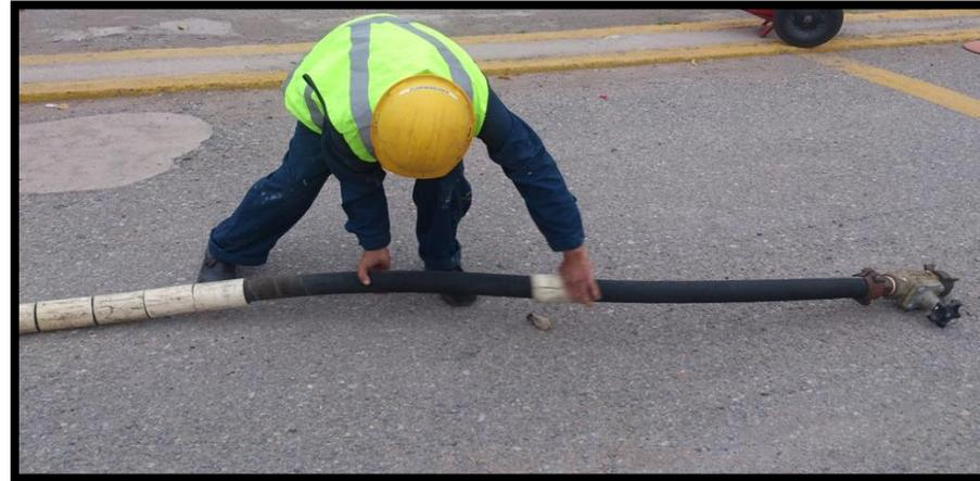
Imagen 8. Inspección del estado físico de las mangueras para GLP.
