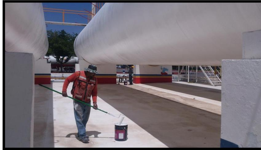
Imagen 9. Aplicación de recubrimiento anticorrosivo.
