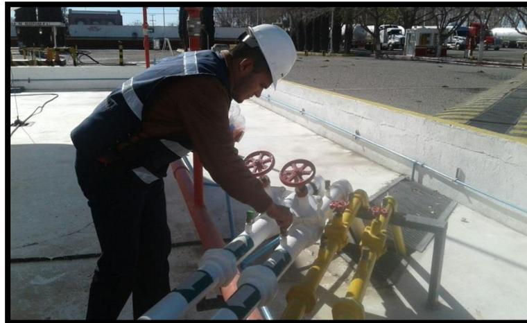
Imagen 4. Reemplazo de tapa para lluvia de la válvula de alivio.
