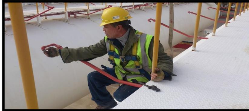
Imagen 5. Mantenimiento de aspersores en GCV.
