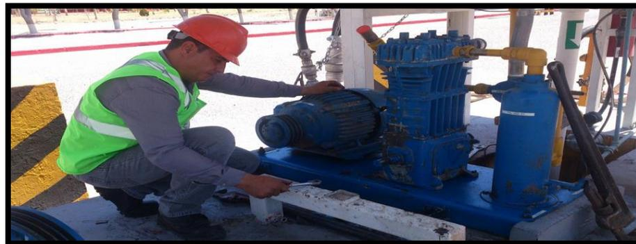
Imagen 1. Mantenimiento a compresores de GCV.
