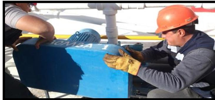
Imagen 2. Mantenimiento a bombas de GCV.
